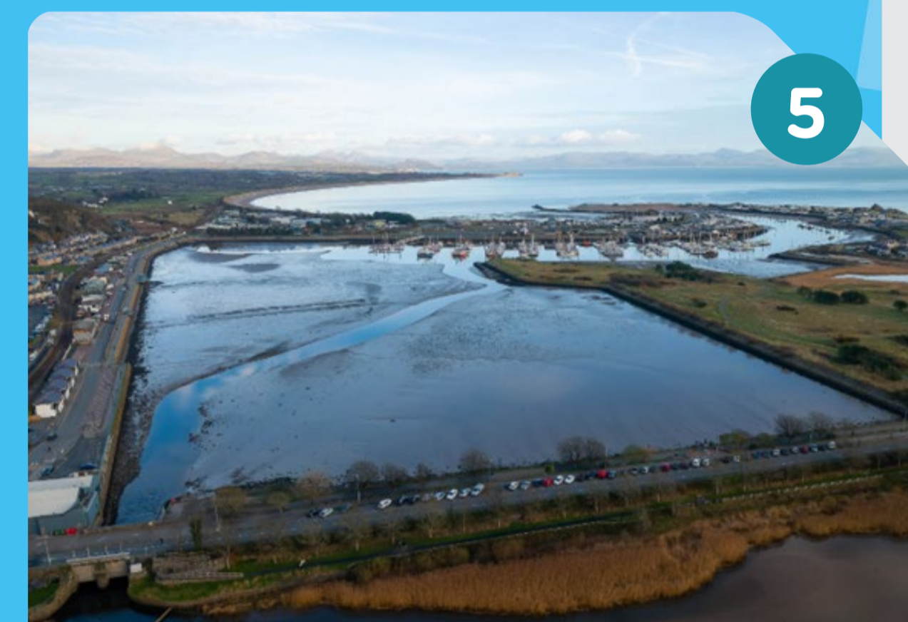
Ffordd y Cob Embankment
